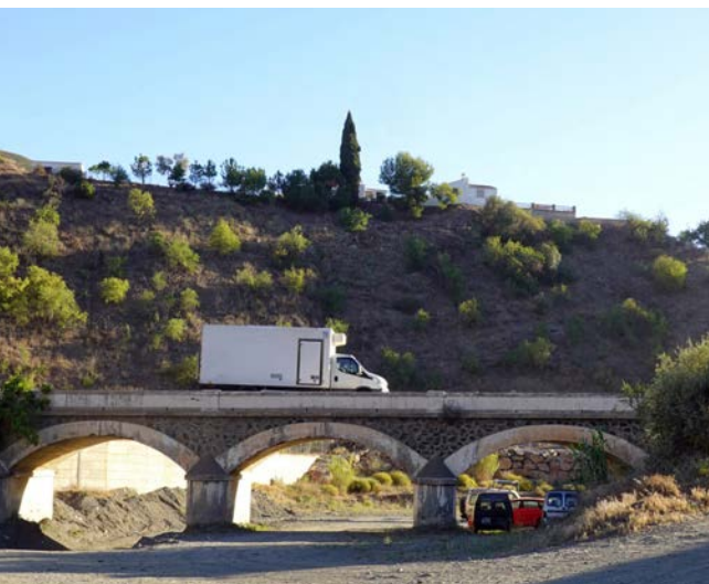
◀ Puente sobre el Almáchar
